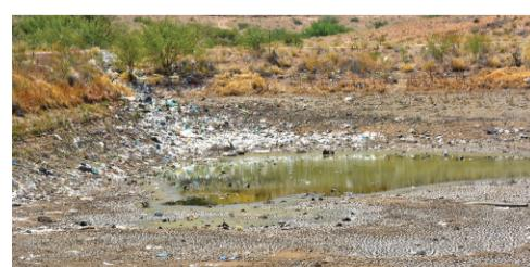
Die oksidasiedam was baie leeg, maar kan aan die hoë temperatuur van die afgelope maand toegeskryf word. Daar is geen rubbervoering in die dam nie en die riool sypel heel waarskynlik in die dorp se ondergrondse watersysteem in.
