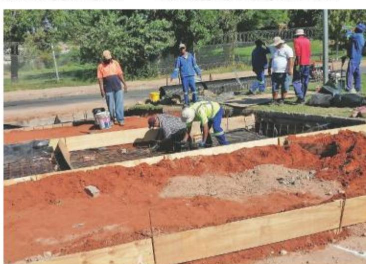
Die voorgeskrewe oplossing is sodanig dat die segment met gewapende beton vervang gaan word en die konstruksie metode behels dat die beton in verskillende segmente plaasvind.
