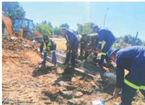
Die stormwaterpyp is ook vervang, nadat die uitgrawingsproses aan die lig gebring het dat die pyp by die las gebreek was.
